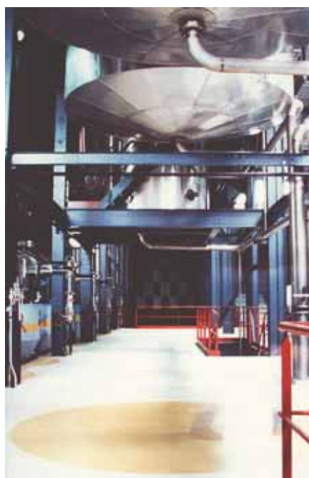
Photo 2. Atelier dans une sucrerie. Les couleurs bleues et dégradées traduisent la transformation du sucre en cours de fabrication. Le sol est clair pour éviter le contraste avec les salissures (sucre).
