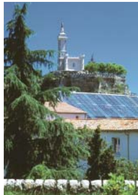
Maison de retraite de Saint-Ambroix, dans le Gard. Production d'eau chaude sanitaire à l'aide de 120 m 2 de capteurs en toiture
