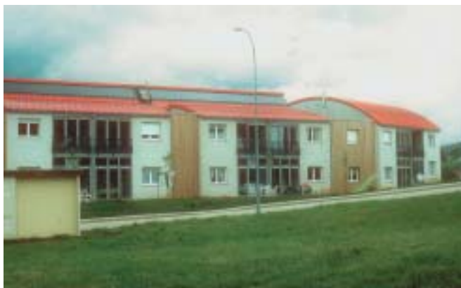
Immeuble collectif d'habitation à Pontarlier, dans le Doubs. 30 m 2 de capteurs solaires thermiques contribuent à la fourniture d'eau chaude sanitaire de quatorze logements.
