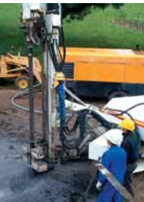
Pose d'une sonde géothermique
