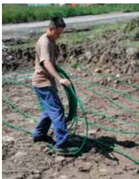
Pose de capteurs horizontaux
